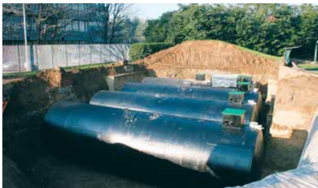
Chiusura del cantiere antincendio in tempi rapidi e definiti a priori
